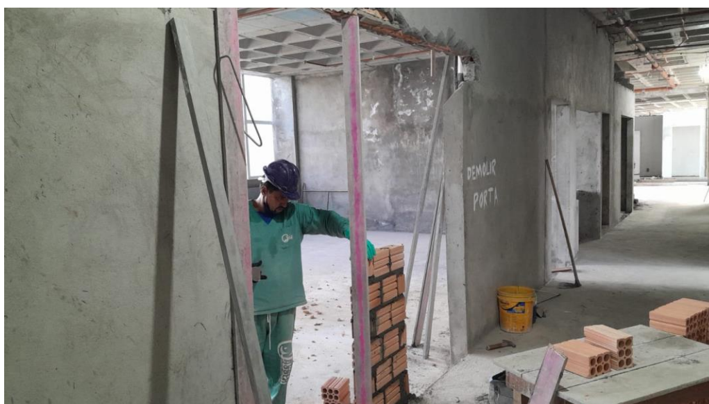
13.12 Alvenaria, Chapisco, Emboço e Requadramento de Porta
